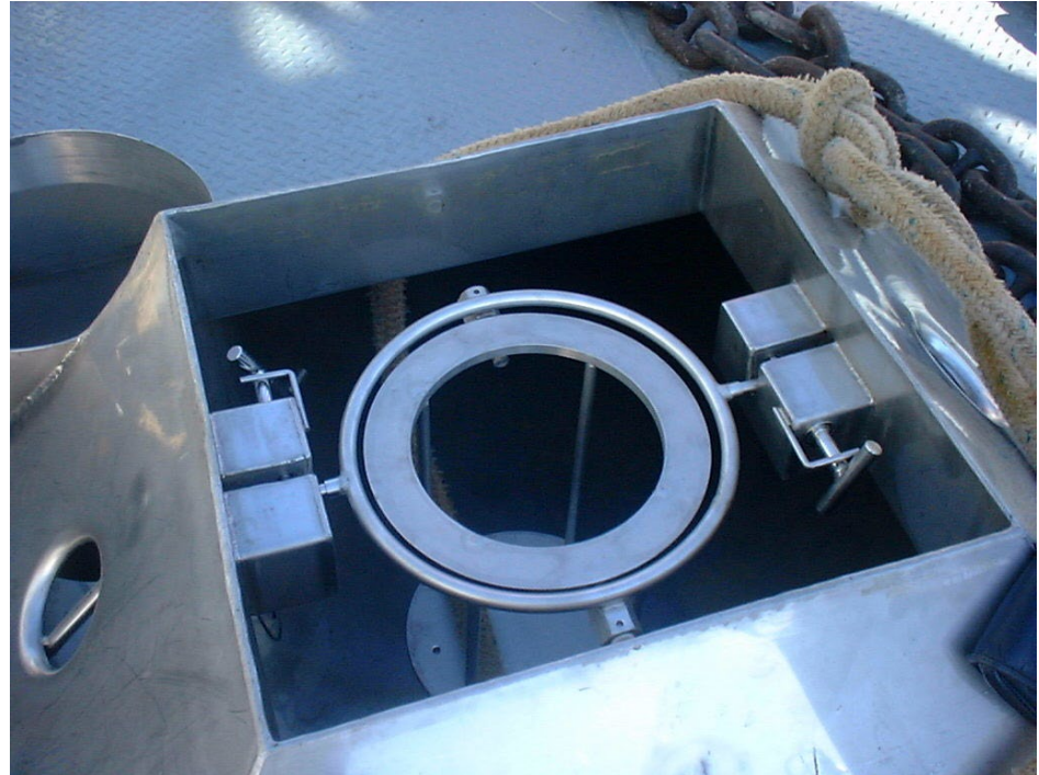
Imagen de la jaula instalada en la piramide metalica.
